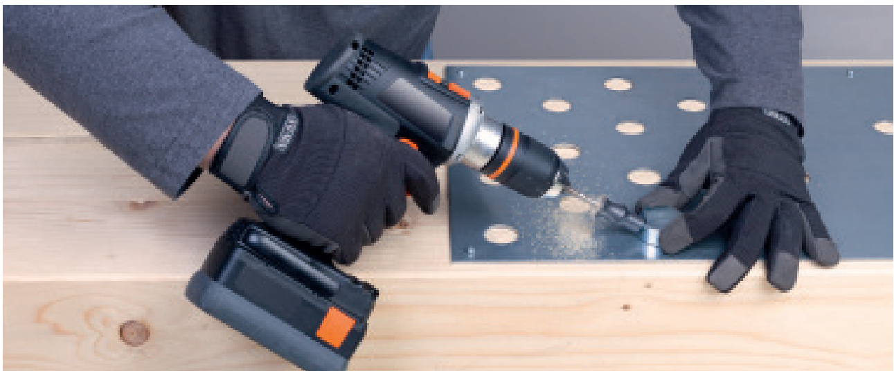
Pré perçage avec le gabarit de perçage BSZYK
