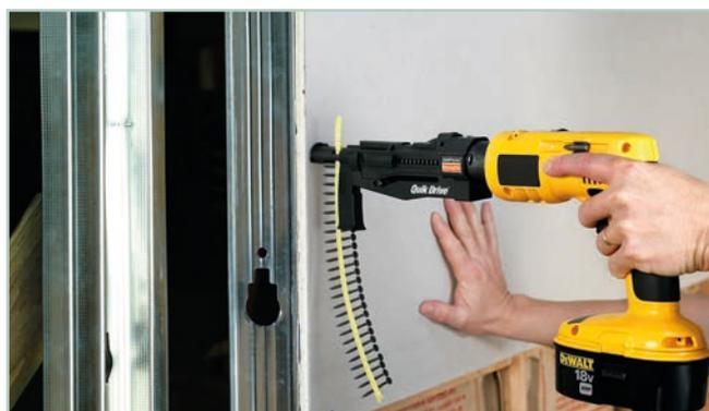
Montage de plaques de plâtre sur structure de métal
