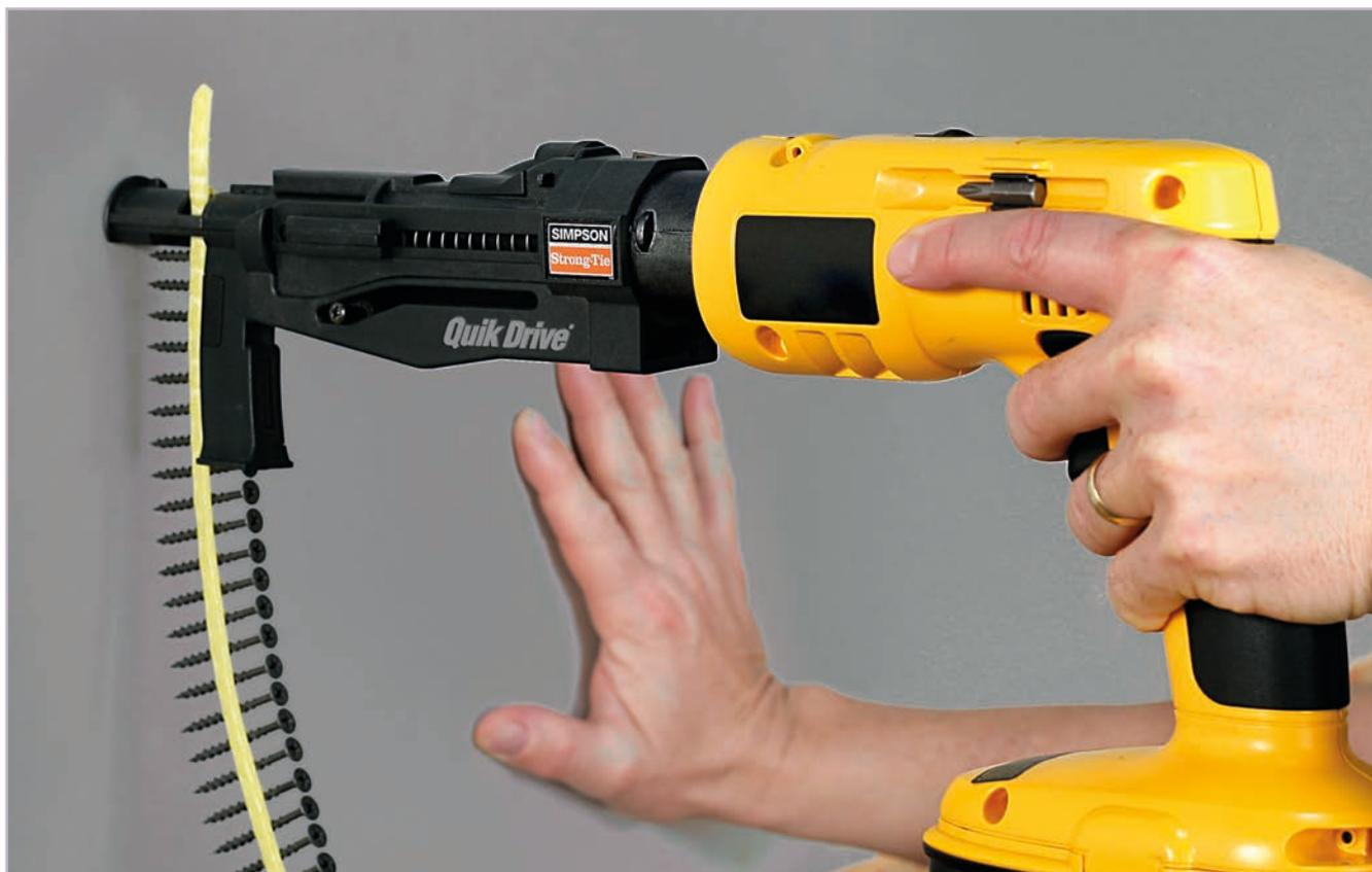
Montage d'une plaque de plâtre sur une structure de bois au moyen de vis de chantier rapides DwC
