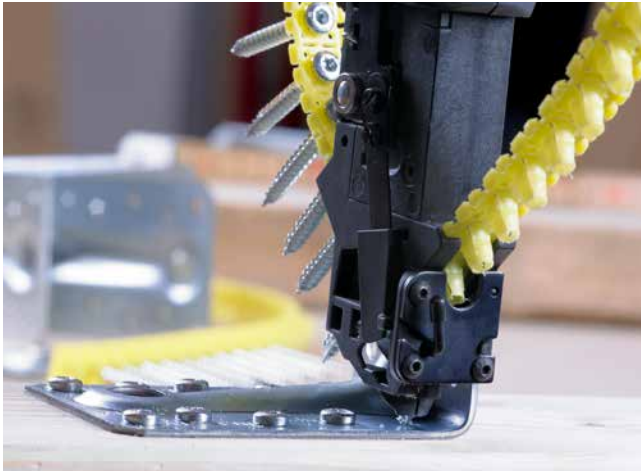
Montage de l'équerre ABR avec vis de connecteur CSA-T
