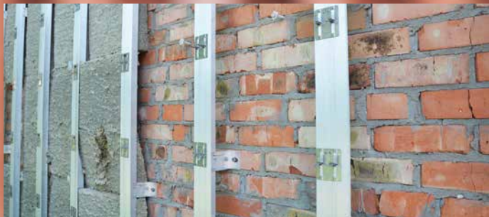
MAÇONNERIE / FENÊTRE / PORTES
