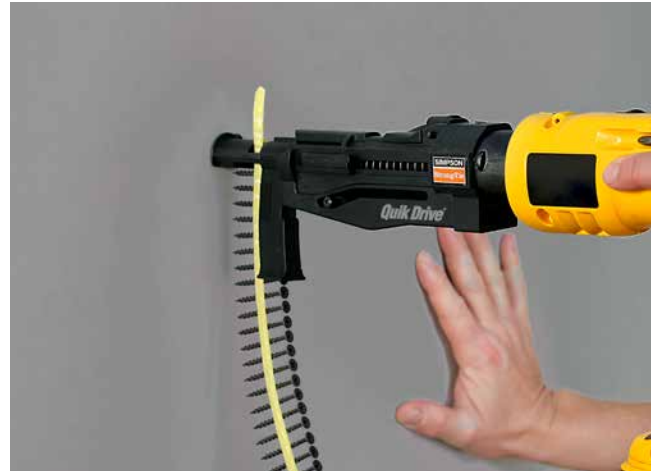
Montage d'une plaque de plâtre sur le montant en bois avec vis à fixation rapide DWC
