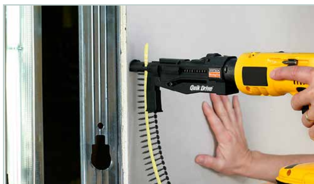
Montage de plaques de plâtre sur montant en métal
