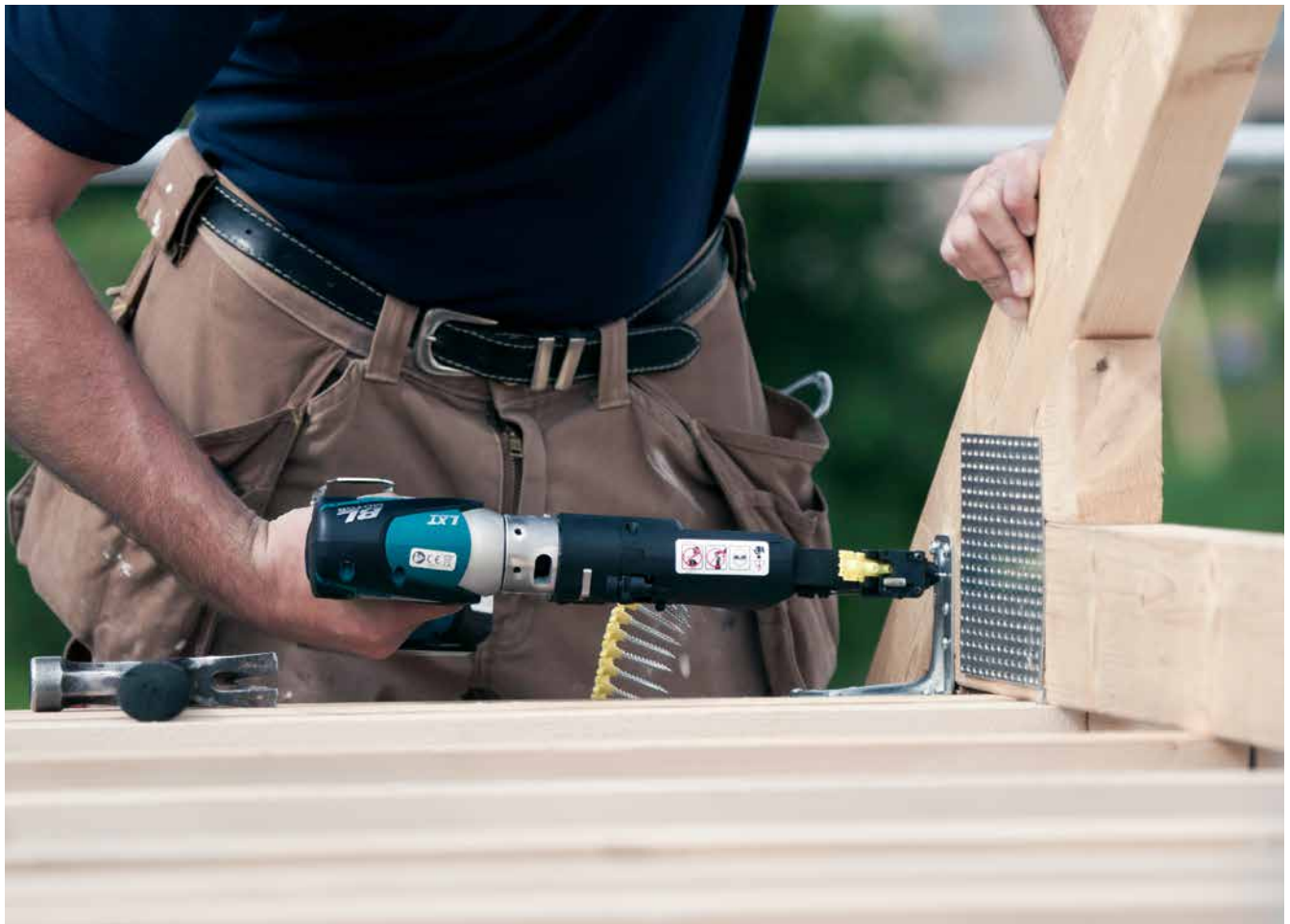
Montage de l'équerre ABR90 avec système de vis à chargeur Quik Drive®. Vous trouverez d'autres connecteurs de bois dans notre catalogue des profilés ou à l'adresse strongtie.de .
